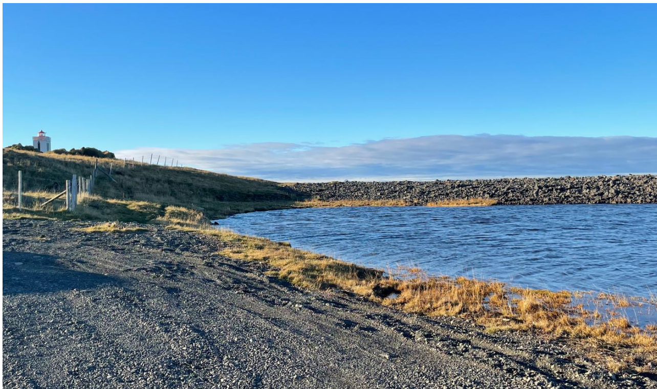
Mynd 5. Séð til norðvesturs frá núverandi bílastæði yfir svæði þar sem gert er ráð fyrir landfyllingu fyrir stækkað bílastæði og þjónustubyggingu.
