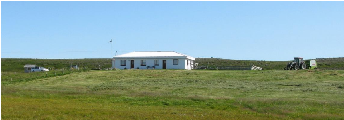
Mynd 1, horft til vesturs heim að Björgum (einnig nefnt Ytri-Björg) fyrir miðri mynd er tveggja íbúða hús byggt árið 1942 (Björg 1 og 3). Íbúðarhúsið á Syðri-Björgum (eða Björgum 2) stendur um 200m sunnar, byggt árið 1952.
