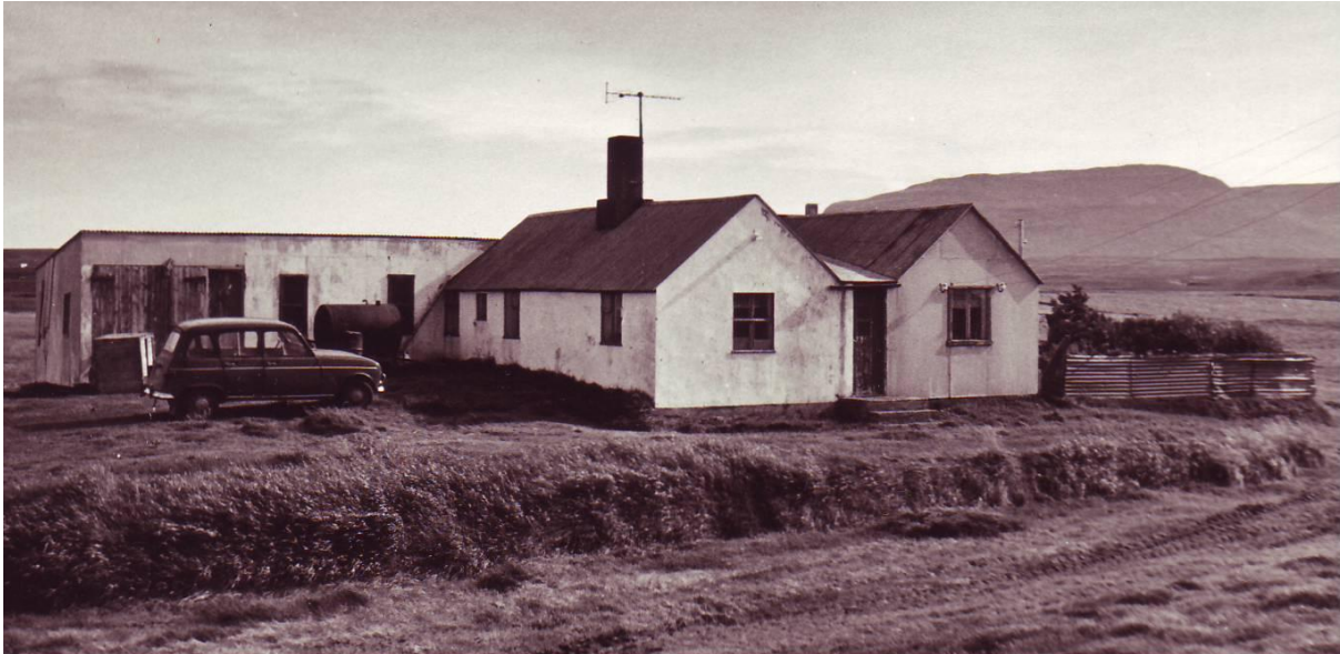
Mynd 70, gamla íbúðarhúsið í Króksseli (b. 1941). Ljósmynd: Héraðsskjalasafn Austur-Húnavatnssýslu.
