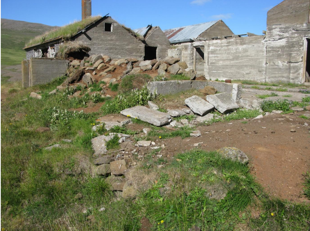
Mynd 25. Fjósveggur stendur enn uppi, hlaðinn úr torfi og grjóti en neðst á mynd sést í grjóthlaðinn kant sem líklega hefur tilheyrð gamla bænum. Horft er til norðvesturs.
