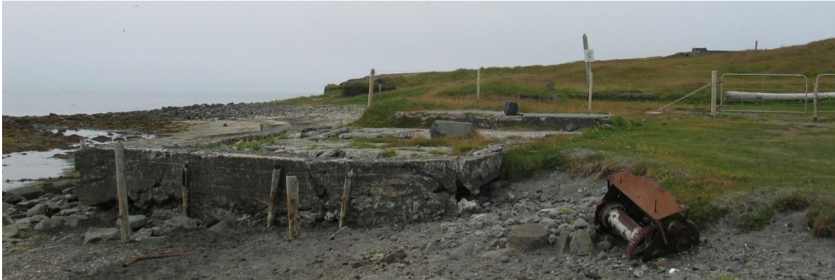
Mynd 7, horft VSV yfir grunn svonefnds Salthúss sem var byggt skömmu fyrir 1900.
