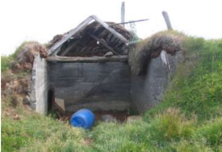
Mynd 4. Horft er framan á húsið Sæmund.
